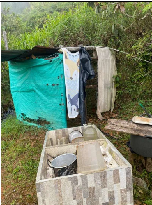
Fotografía 4. El baño cuenta con un cerramiento de plástico y lona, con cubierta en tejas de zinc y un piso de tierra pisada. Las vigas presentan inestabilidad debido a los efectos de la humedad.
